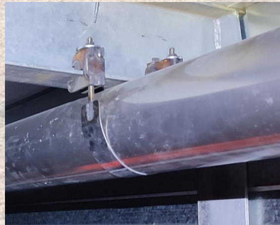
Крепежные элементы для монтажа воздуховодов внутри камер
