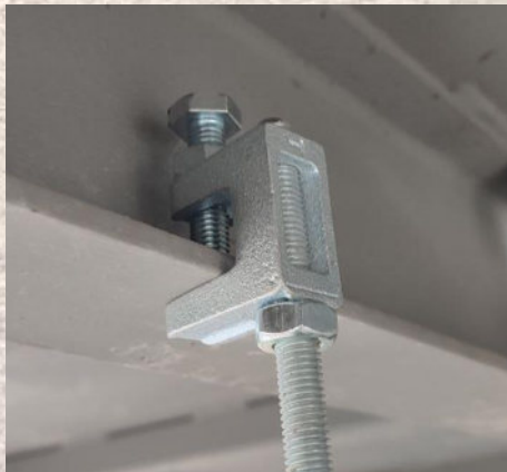
Крепежные элементы для монтажа воздуховодов внутри камер
